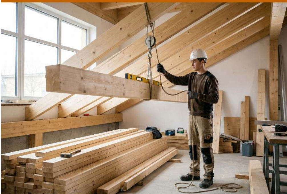
Monter une panne pour un appentis de 20 m 2 avec précision
